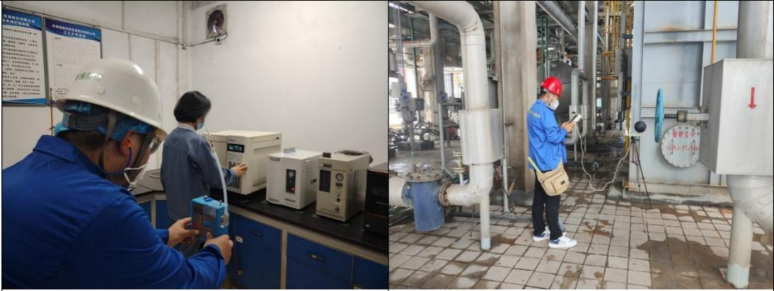
现场检测照片
